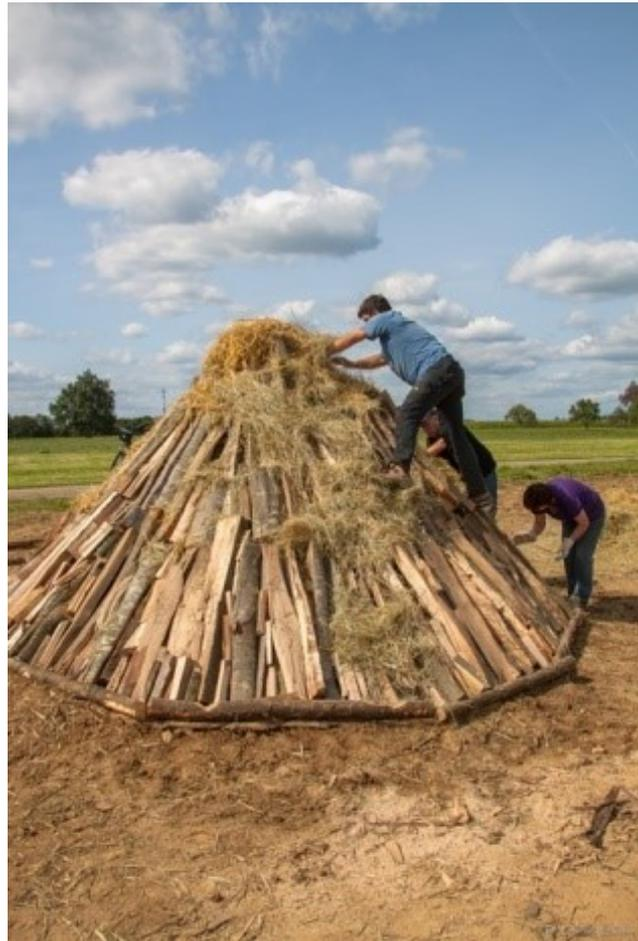
*Der Meiler wird gegen Eindringen der Lösche abgedichtet*
