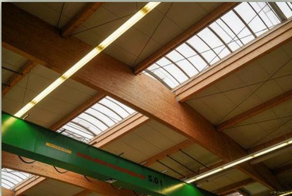
*Dachträgerkonstruktion der Schaffitzel-Produktionshalle aus Brettschichtholz*
